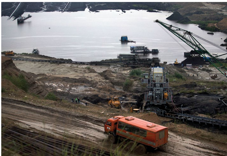
Грузовик проезжает мимо затопленной открытой угольной шахты в г. Костолац, в 70 километрах к востоку от Белграда, столицы Сербии. Июль 2014 г., через два месяца после разрушительного наводнения, обрушившегося на страну. АССОЦИИТЕД ПРЕСС
